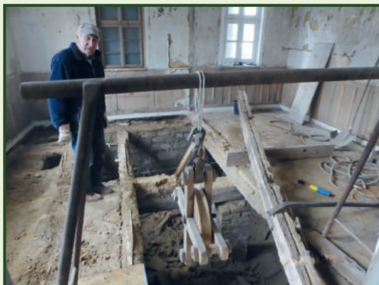
Bernd Reichert beim Rückbau der maroden Kriechkellerdecke Quelle: DEK
