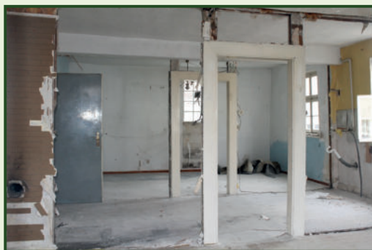
Das Alte Amtshaus nach der Entkernung Quelle: DEK
