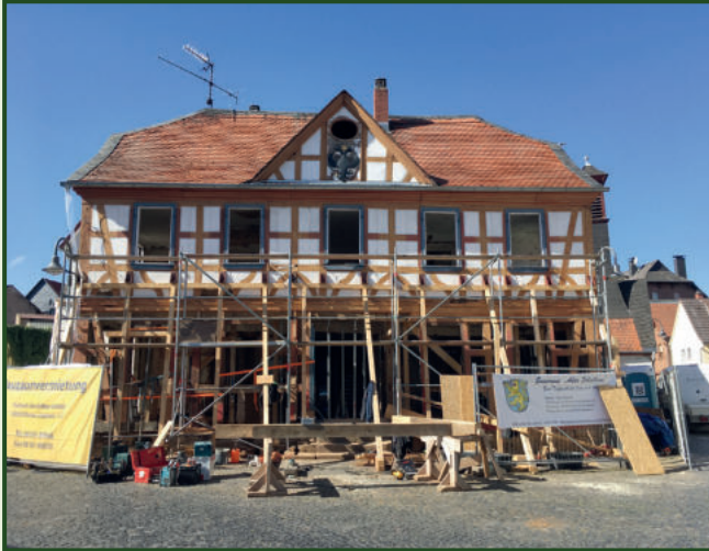
Sanierungsarbeiten im September 2018
